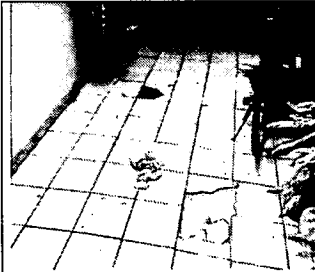
八堵煤礦-高銀城老先生家地板隆起與龜裂
