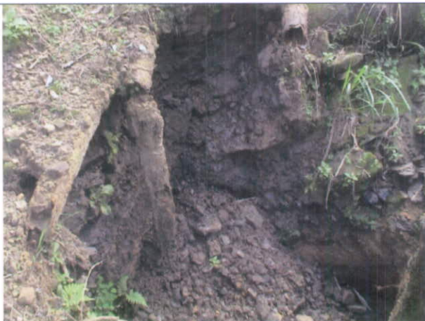
八堵煤礦坑口前方邊坡礦渣堆有異常塌陷情形
