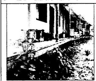
八堵煤礦區萬礦長家屋後地基已墊高約1公尺
