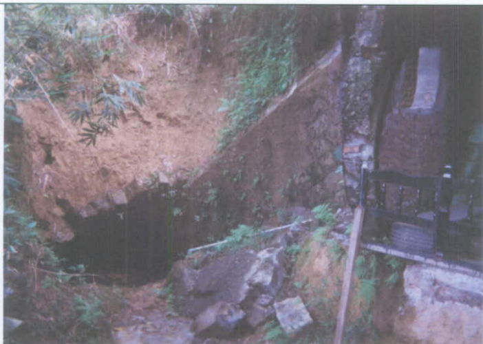
億達煤礦(三合煤礦一坑)-風坑口之上盤岩體及土體已落盤且積水
