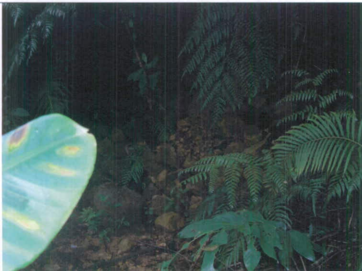
萬山煤礦坑口旁之佛峰寺後方邊坡有落石崩塌現象
