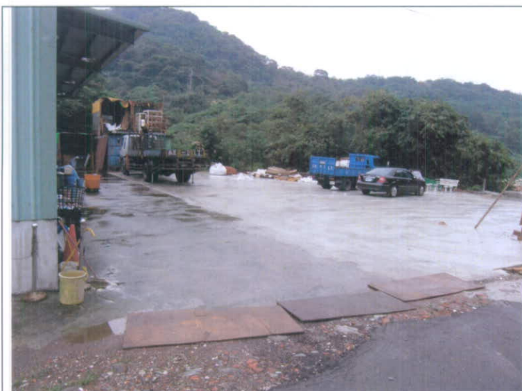
東運瓷土礦92年舊崩塌陷區現已為廠房(聲稱已無持續之塌陷)
