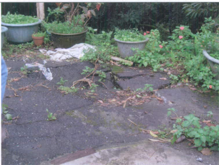
萬山煤礦張林碧蓮屋前因位處坑道上方，其地表數處凹陷且龜裂持續發生
