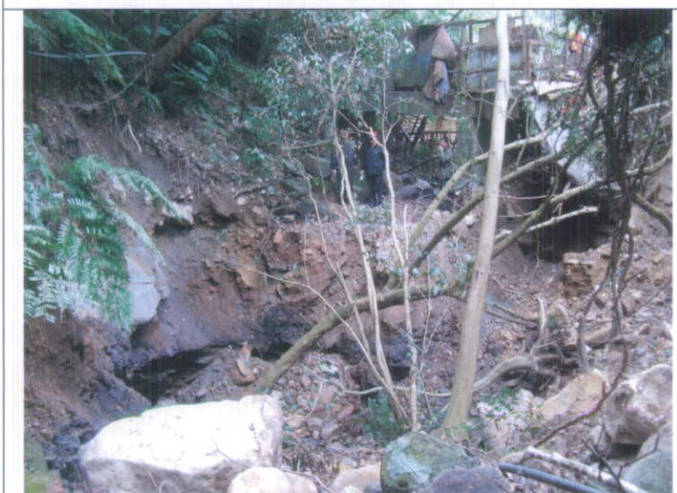
東運瓷土礦於97年1月之地表塌陷區
