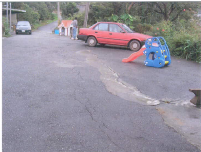
萬山煤礦張林碧蓮屋前地表數處凹陷已回填，且地表裂縫甚長，電線桿傾斜，且持續發生
