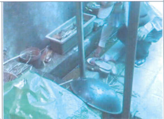
英和坑口位於住宅後方，雖已封閉，但仍有銹水湧出。
