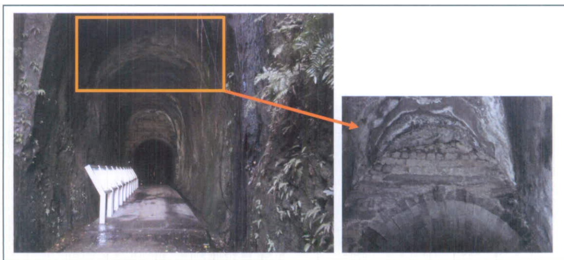
圖 59 第二類廢棄坑道：基隆市劉銘傳隧道（獅球嶺隧道）因有良好之坑壁襯砌以及地方政府之維護，現為知名古蹟與觀光景點
