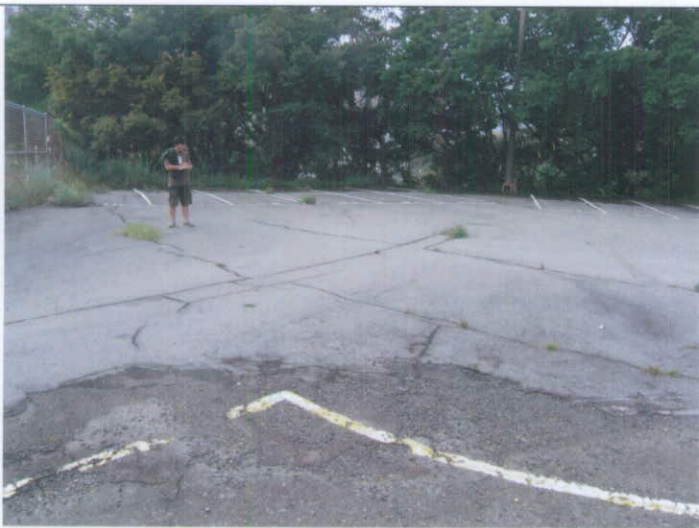
豐田煤礦坑口上方舊訓練場有大型裂縫及地表沉陷現象(遠處下方即為坑口)
