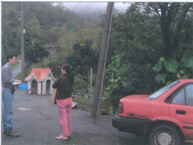
萬山煤礦張林碧蓮屋前地表數處凹陷已回填，且地表裂縫甚長，電線桿傾斜
